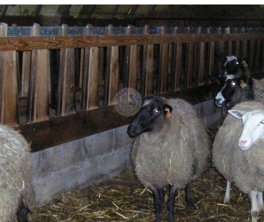
Couloir d'alimentation avec cornadis et base du passage de tête à 50 cm (sans marche) ou 70 cm (avec marche) du niveau du sol avant paillage.
