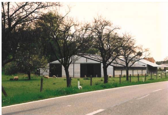
Bâtiment avec 4 parcs d'élevage longitudinaux
