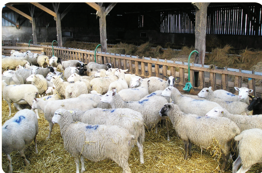
Bergerie avec disposition longitudinale des parcs, auges avec passages de têtes verticaux et entrée d'air par bardage ajouré.
